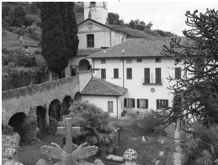
Gli esterni dell'Abbazia dell'Acquafredda nelle attuali condizioni di degrado.
